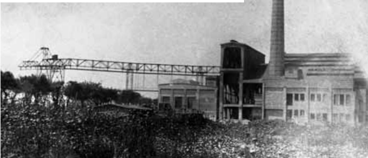
La fabbrica era dotata di un raccordo ferroviario che si diramava dalla vicina linea Fiumicino-Ponte Galeria. Le materie prime per la produzione del vetro venivano approvvigionate tramite una teleferica che collegava il vicino canale navigabile con le tramogge dei forni. Fu l'eccesso di pro-
